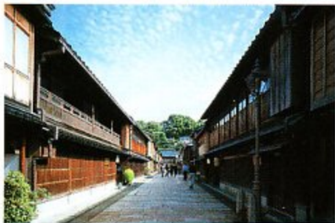
上：南側立面。重要伝統的建造物群保存地区にあるため外観は保存継承されている。下：前面の通り。
